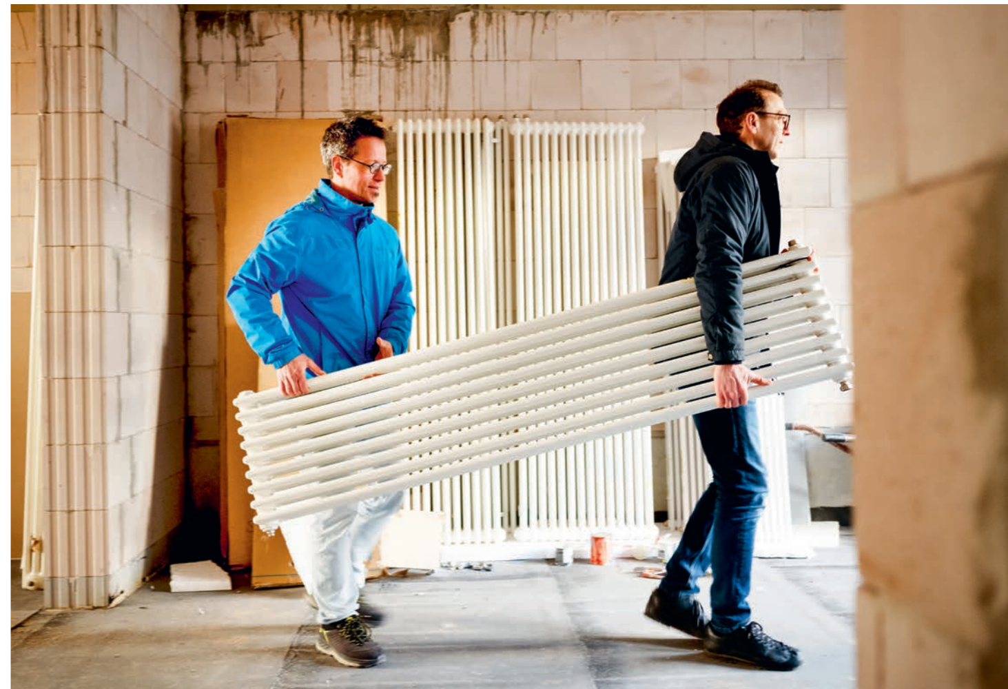
Secondhand: Die Baugruppe setzt in ihr Traumhaus gebrauchte Heizungen, Fenster und sogar Backsteine ein.
