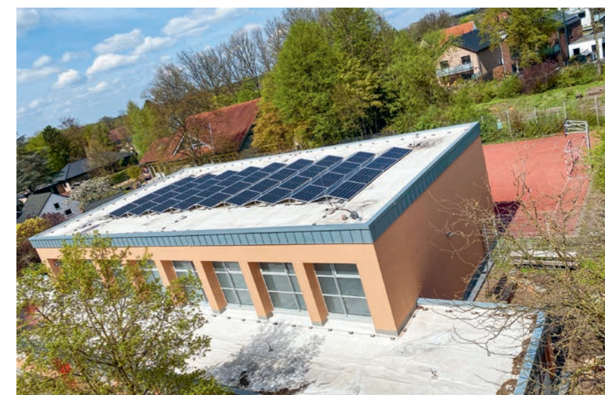
Neben einer Photovoltaikanlage auf dem Dach wurden zahlreiche weitere energetische Maßnahmen umgesetzt.
